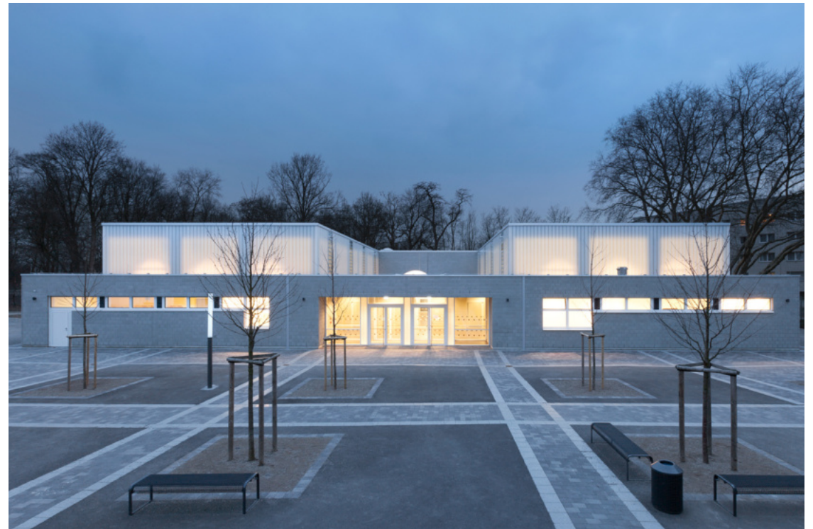
Turnhalle Görlinger Zentrum - Gebäudewirtschaft Köln
